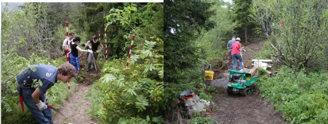
Lernende der CS am bau der Pfyffentreppe
